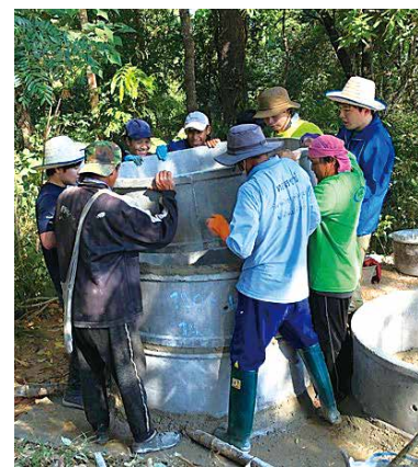
タンク建設の様子
